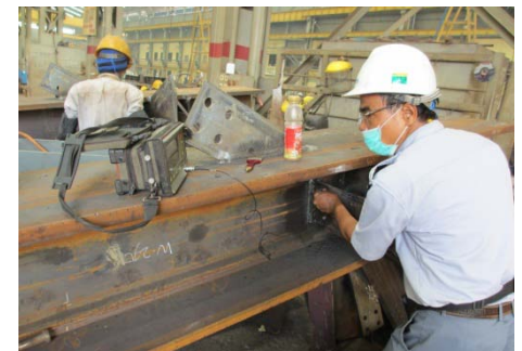
工場In-houseの溶接部検査員
