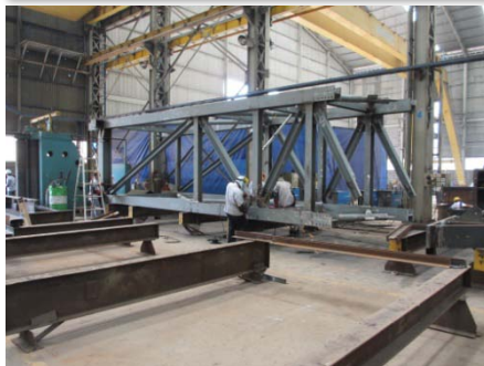
展示場屋根トラス構造を製作中
