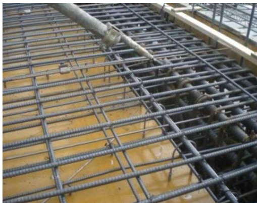
照片 悬挑楼板的配筋
