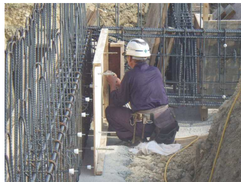
基础 对侧支模
