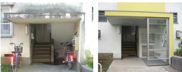
改建前后（中层住宅楼梯间）
