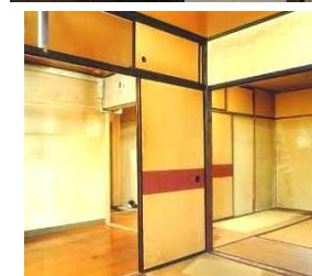
施工前（厨房、室内、浴盆）
