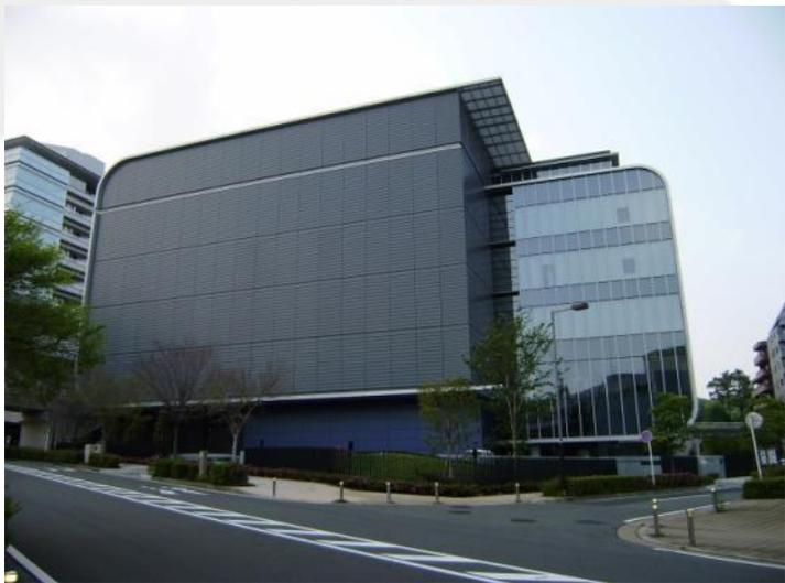
该ND项目位于神奈川县横滨市都筑区，共6层，项目由日本清水建设有限公司总承包。该项目外墙全部采用涂装（外墙仿金属）PC板。
