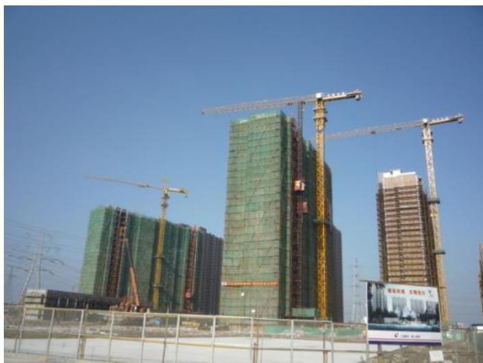
上海万科金色里程位于浦东高路，19层。该小区外墙全部采用外墙面砖PC板。
