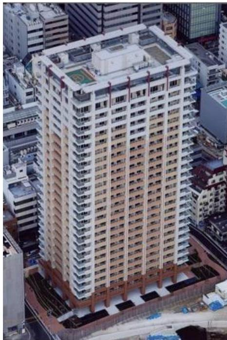
该项目位于东京都品川区东五反田，26层，项目由日本清水建设有限公司总承包。该项目外墙全部采用瓷砖PC板，墙、柱、梁均为预制构件，现场施工拼装。
