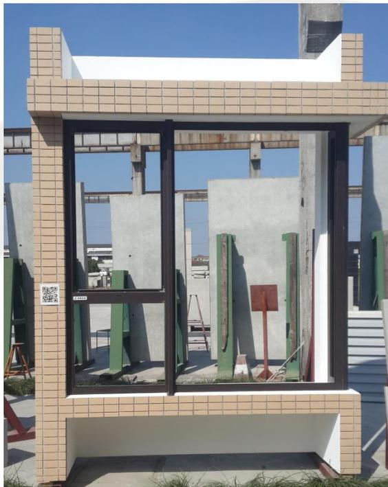
预制混凝土瓷砖饰面飘窗板
