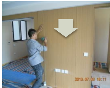
安装移动隔墙
