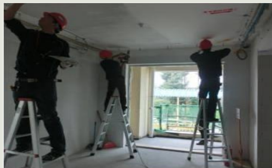
室内吊顶打孔
